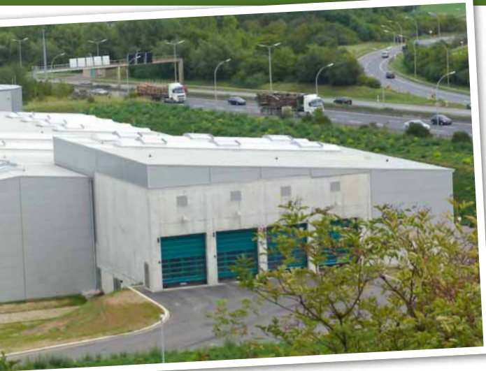
Vue de l'installation de méthanisation 2011
