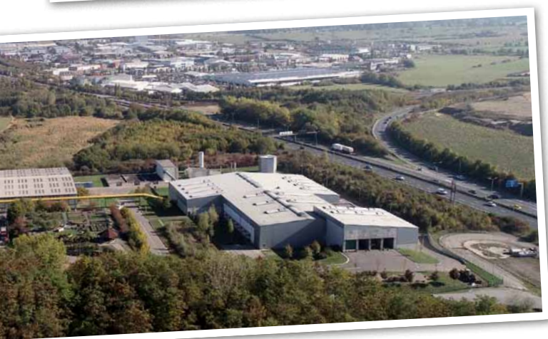
· Vue aérienne des installations du syndicat
