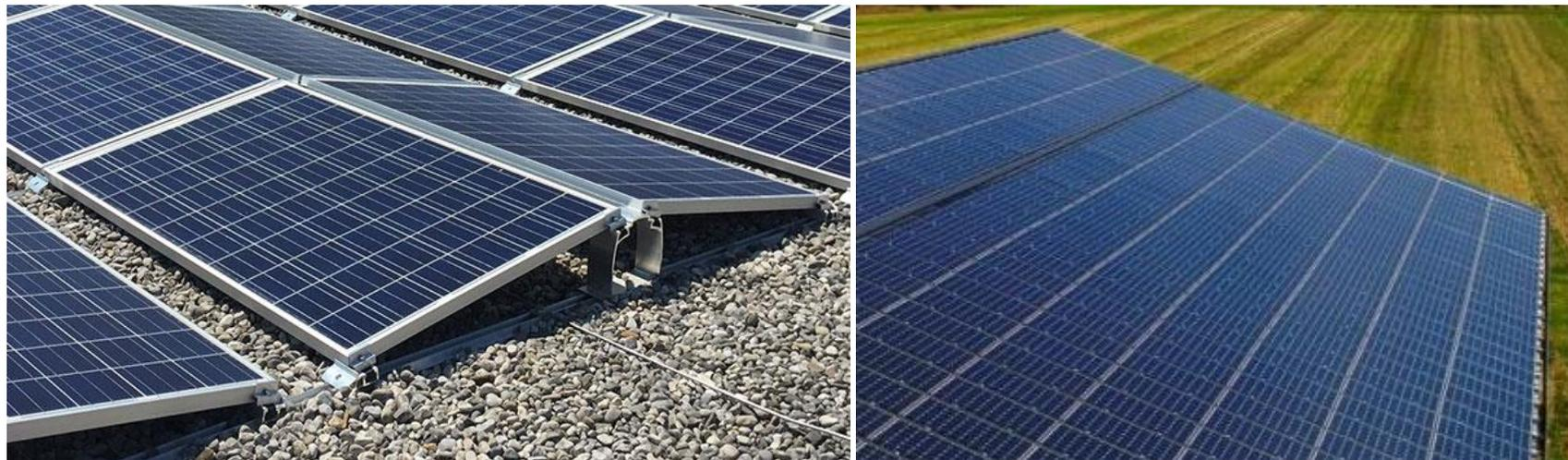
Illustration 4.7.1 : exemples de l'implantation des panneaux solaires sur la toiture plate et inclinée
