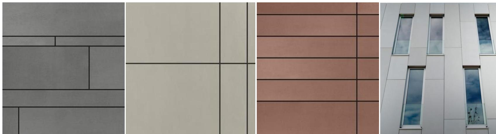
Illustration 4.1.4.1 : exemples de façades en fibre-ciment et béton fibré
