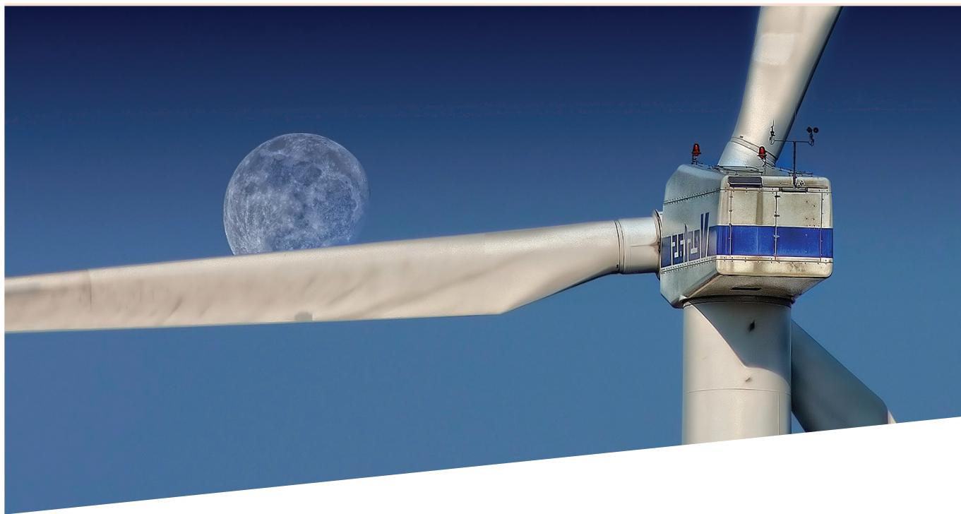
E115 Windenergieanlage mit einer Nabenhöhe von 149 m und einer installierten Gesamtleistung von 3,5 MW.
